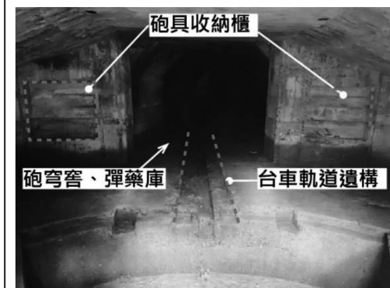
【圖50】掩體內部和穹窖入口情形
