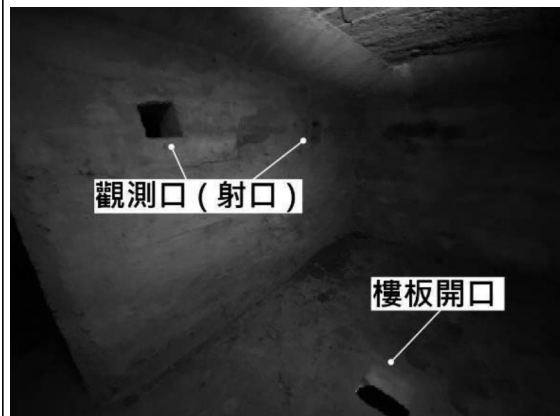
【圖38】中層隔間觀測口和樓板開口
